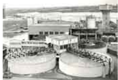
Décanteurs de lavage.
