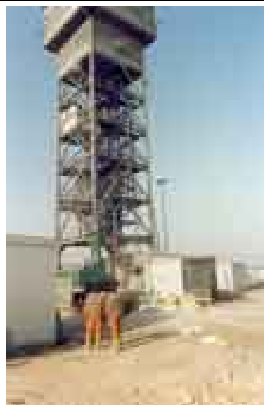
Tour d'extraction de l'Ecarpière avant sa destruction 1992.
