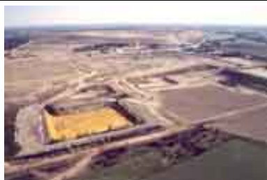
Bassins de sécurité des effluents avant leurs rejets à la rivière, en 1996.
