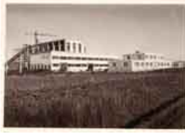
Construction de l'usine La SIMO, en 1956.
