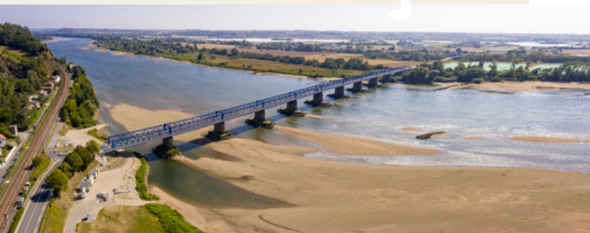
Ponts de Mauves © Région des Pays de la Loire - PB. Fourry
